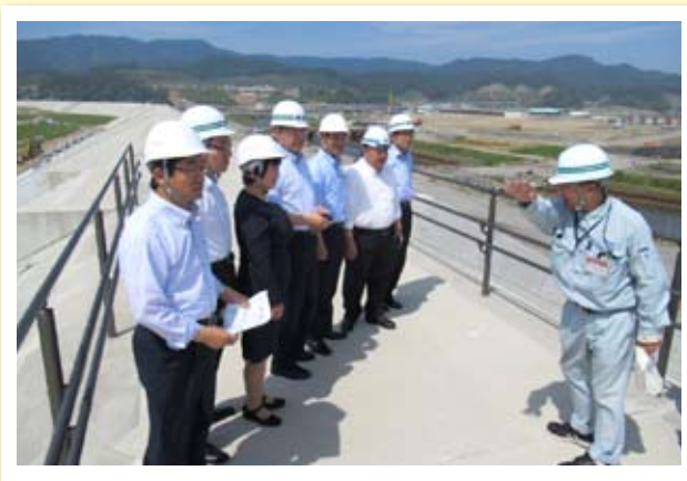
▲岩手県陸前高田市の高田地区海岸に整備中の高さ12.5メートル、全長2キロの防潮堤を視察(左端が三宅府議)【6月29日】
